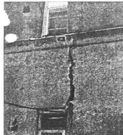
Сквозная раскрытая трещина в несущей стене жилого здания (Калининград, ул. Аральская).
